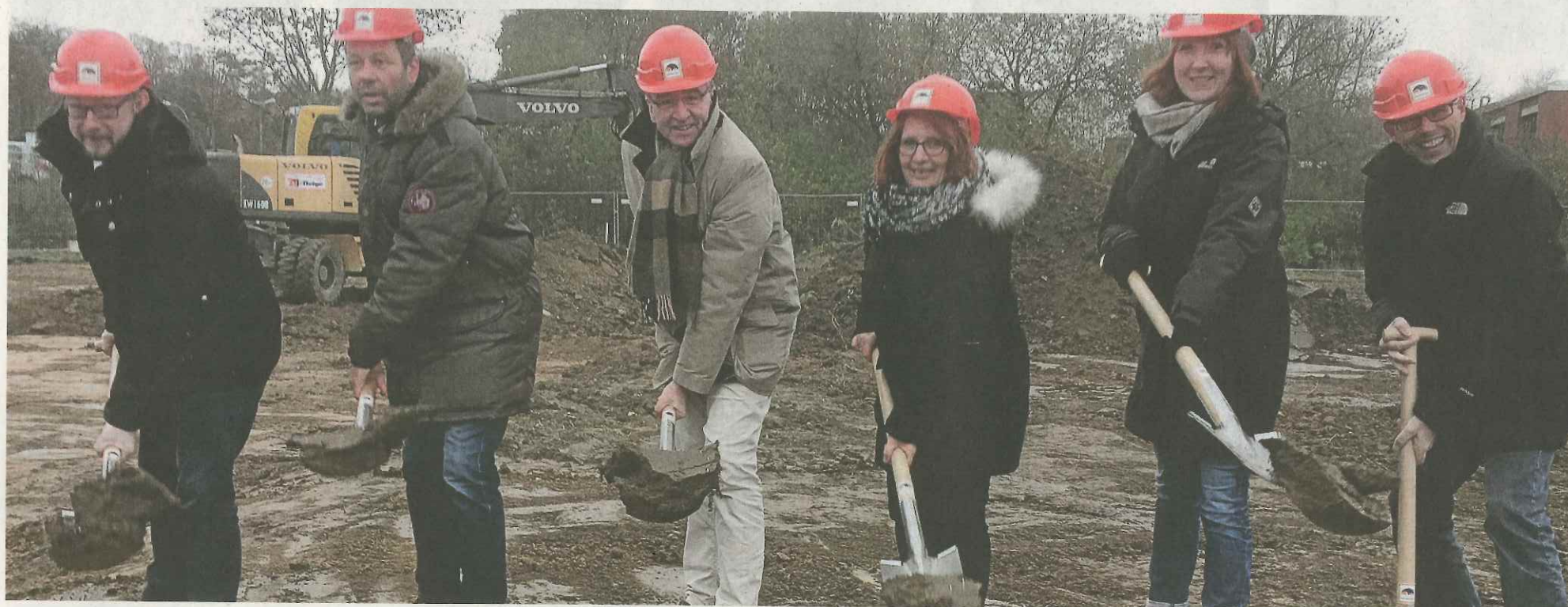
Ivica Lucanic, Thomas Möhlendick, Thomas Pink, Claudia Hesebeck, Olga Schell und Knut Foraita (von links) beim ersten Spatenstich für den neuen Kindergarten Am Sonnenhang. Ende nächsten Jahres soll das Gebäude fertig sein.
